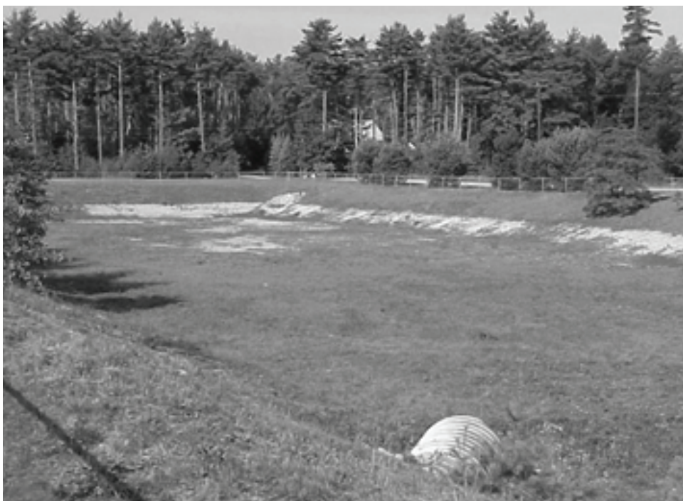
Figur 1 Et større nedsivningsbassin efter godt 10 års drift.
